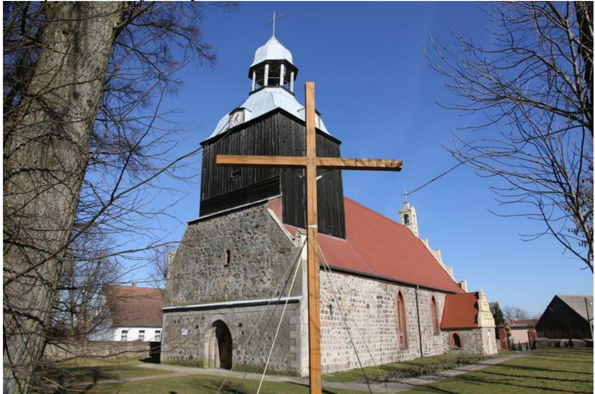
fot. Widok ogólny od strony południowo-zachodniej
