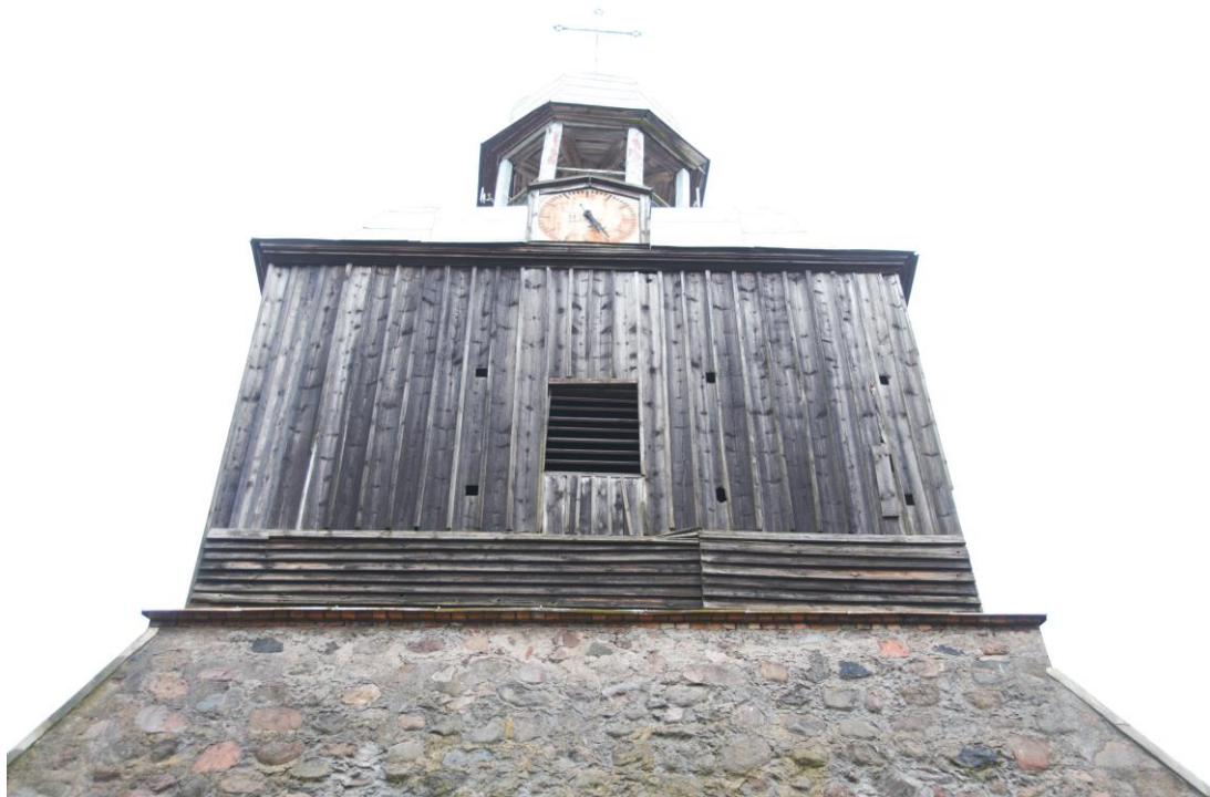
fot. Widok na elewację zachodnią
