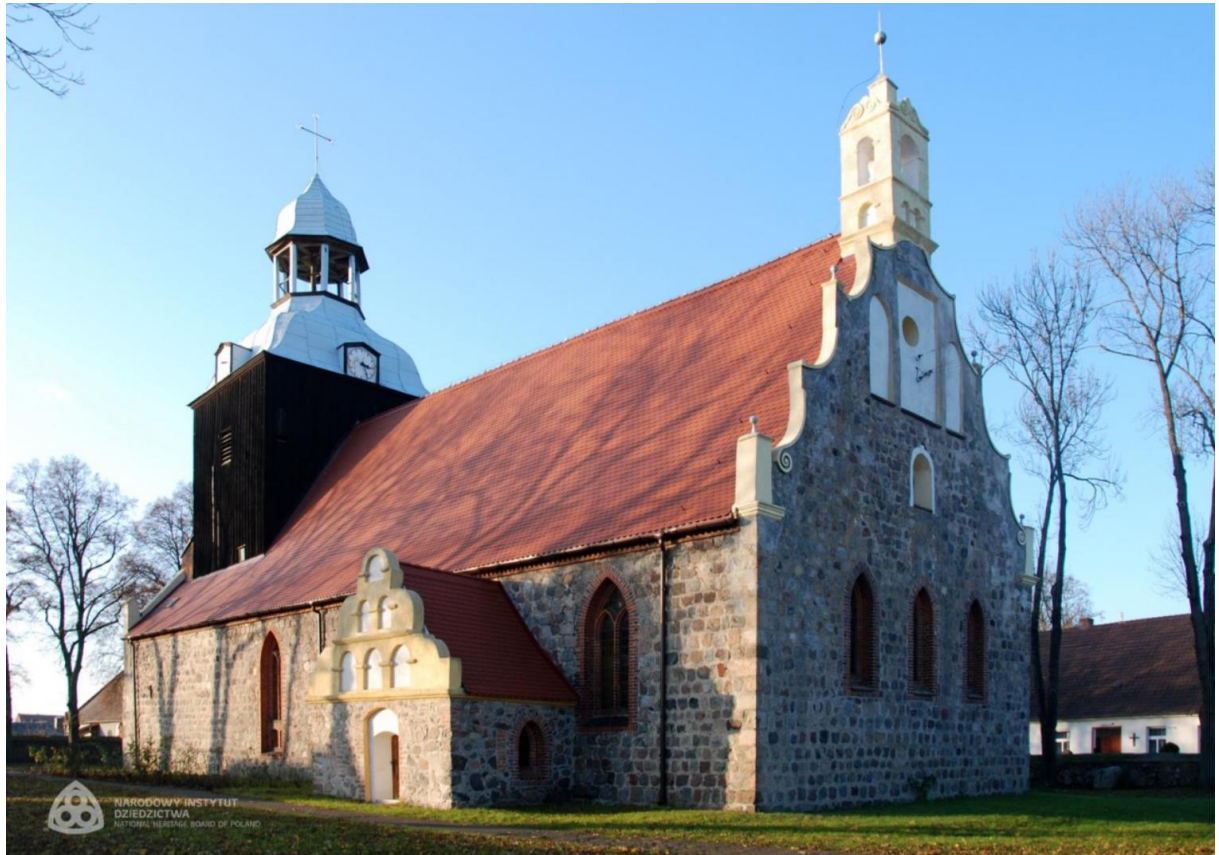
fot. Widok ogólny od strony południowo-wschodniej
