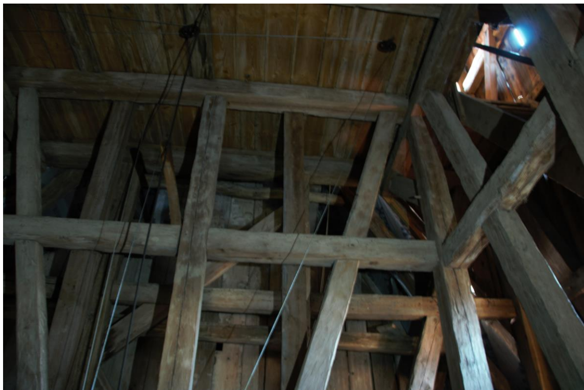
fot. Konstrukcja słupowo-ryglowa w podstawie wieży
