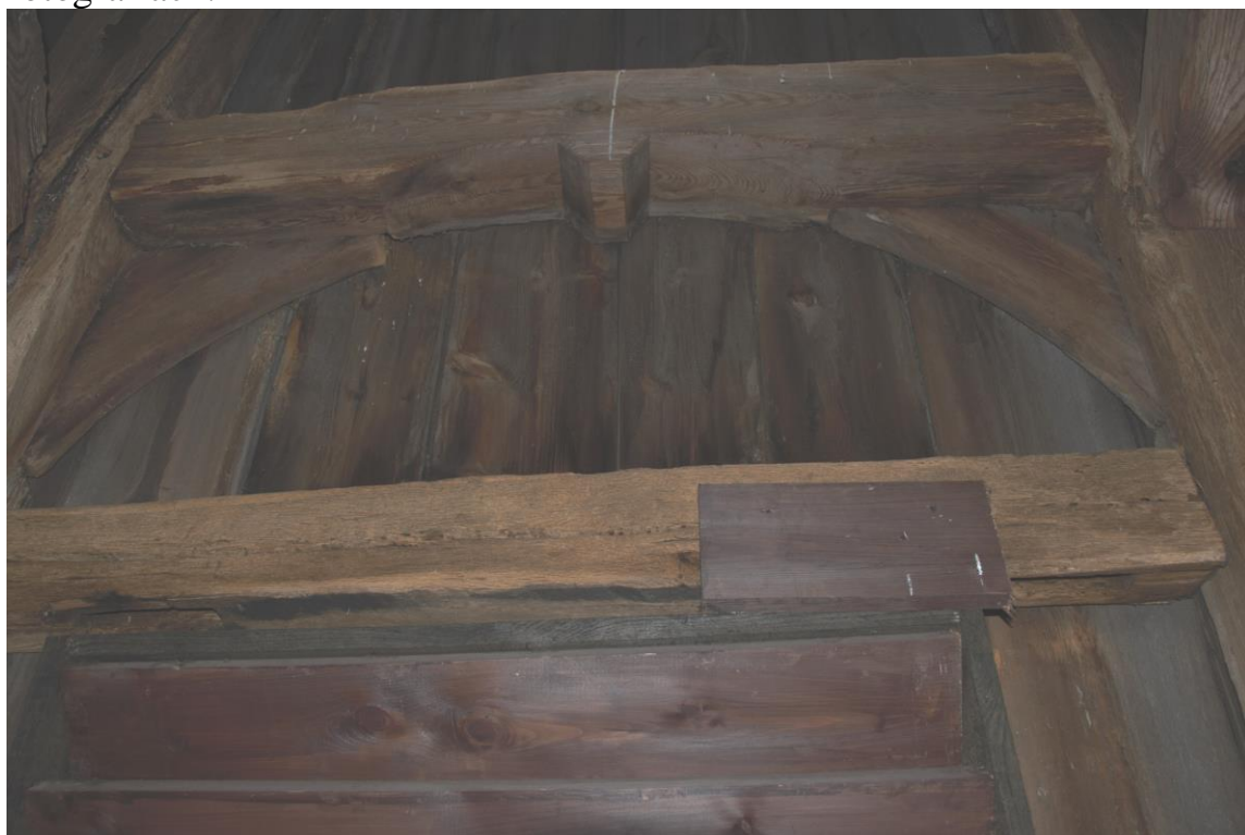
Fot. konstrukcja drewniana ściany wieży z zachowanymi detalami
