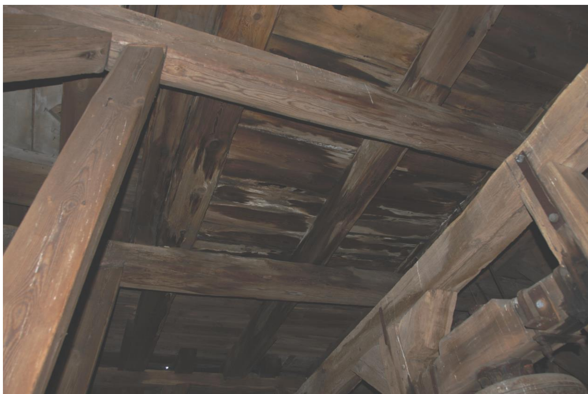
fot. Strop nad poziomem dzwonów
