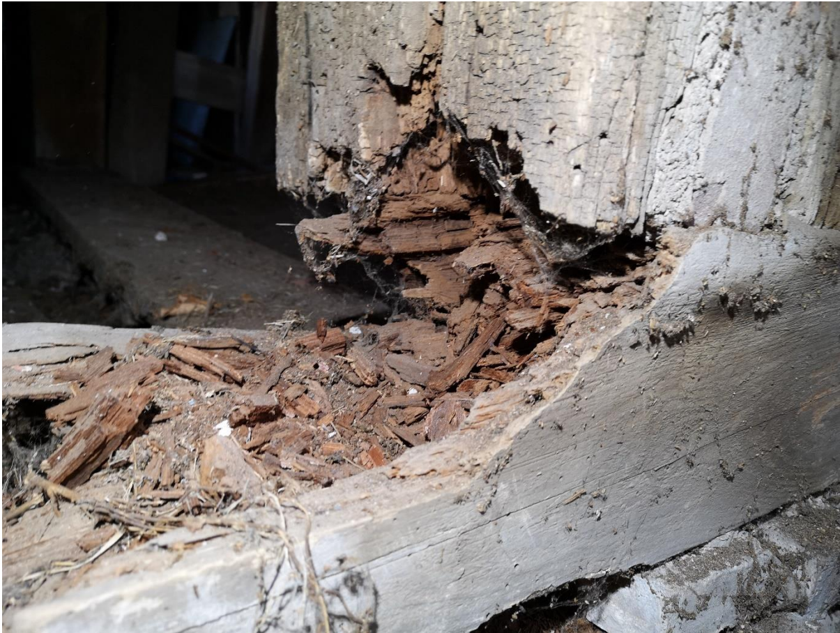
fot. Końcówka słupa zewnętrznego narożnego wieży oraz podwalina
