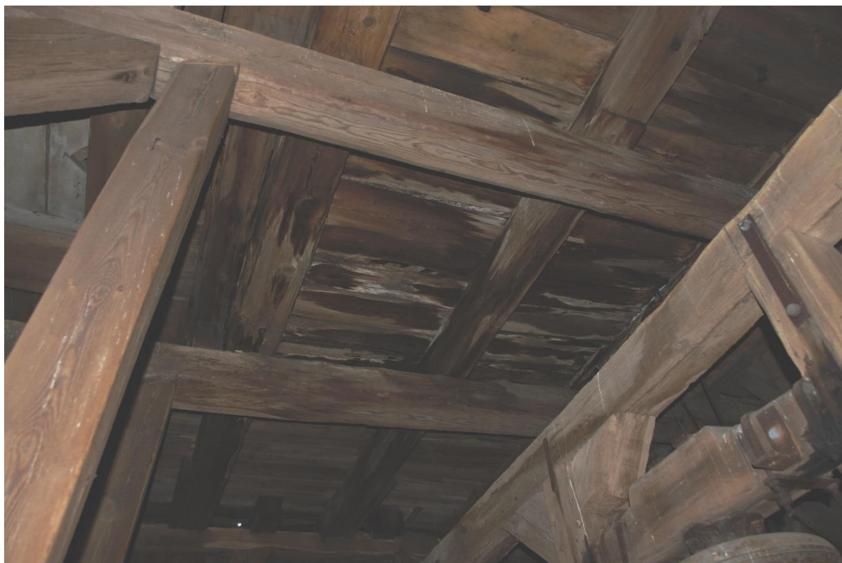
fot. Strop nad poziomem dzwonów
