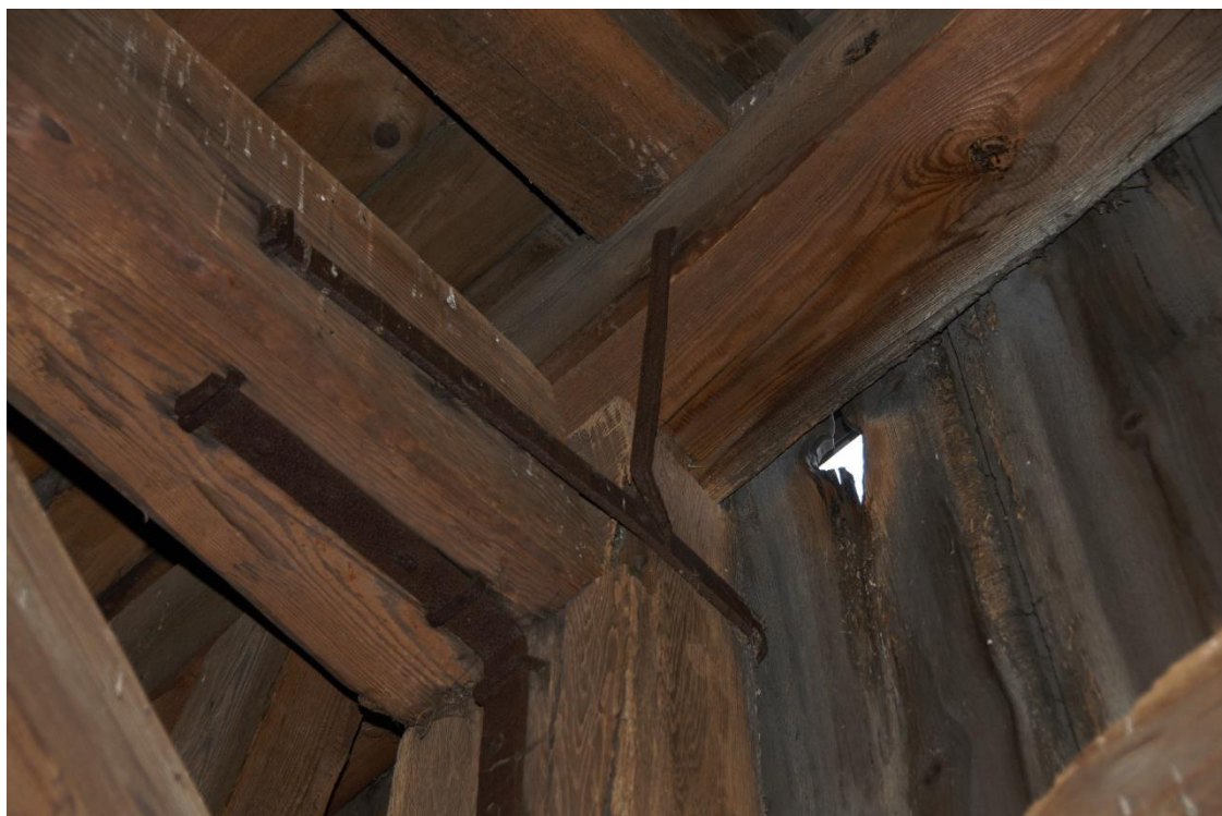
Fot. konstrukcja drewniana ściany wieży z zachowanymi połączeniami
