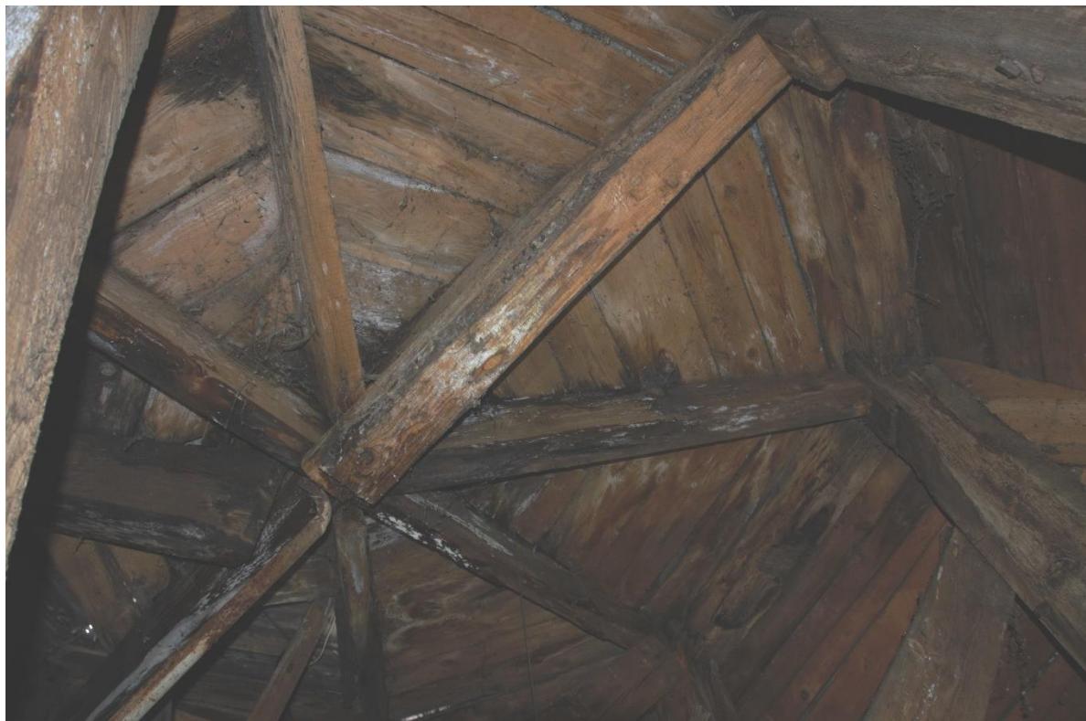
Fot. Strop nad poziomem hełmu z widocznym rozkładem drewna
